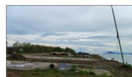
สภาพปัจจุบันก่อนปรับปรุง
