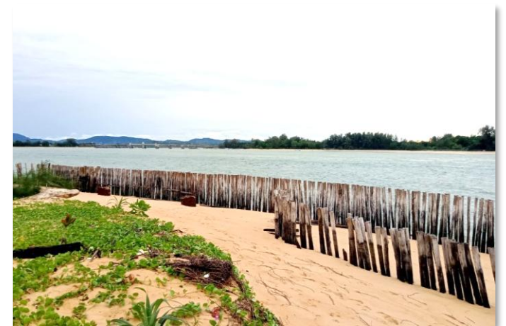
การปักเสาดักตะกอน
