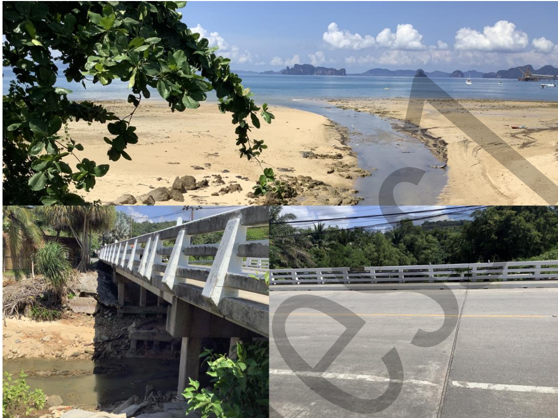
รูปที่ 6.1-12 สะพานข้ามคลองหนองทะเล บนถนนทางหลวงชนบท 6024 บริเวณอ่าวคลองม่วง จ.กระบี่
