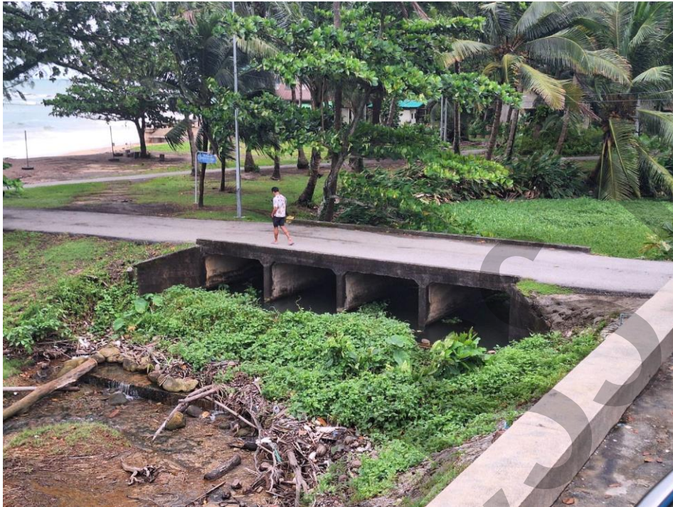
รูปที่ 6.1-9 ท่อลอดเหลี่ยมถนนข้ามคลอง บริเวณหาดเขาหลัก จ.พังงา
