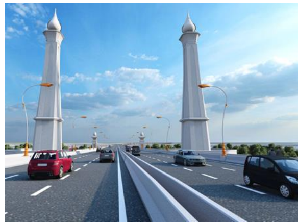
สะพานปทุมธานี3 ระยะทางรวมทางยกระดับ 7.6 กิโลเมตร
