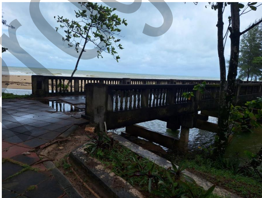
รูปที่ 6.1-8 สะพานข้ามคลอง บริเวณอ่าวบางม่วง จ.พังงา
