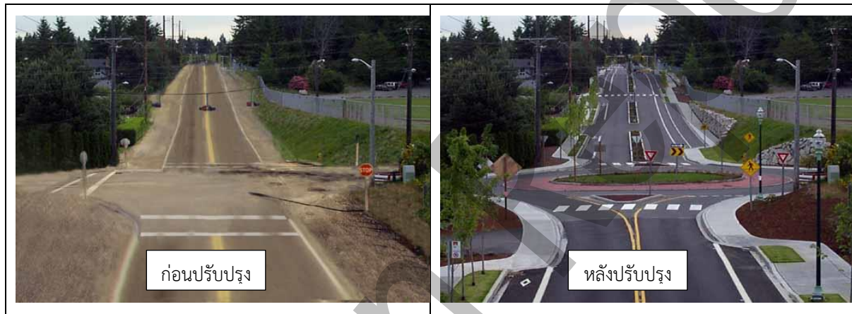
รูปที่ 3.4-3 ตัวอย่างการปรับปรุงทางแยกเพื่อลดจุดตัดกระแสรถจร
